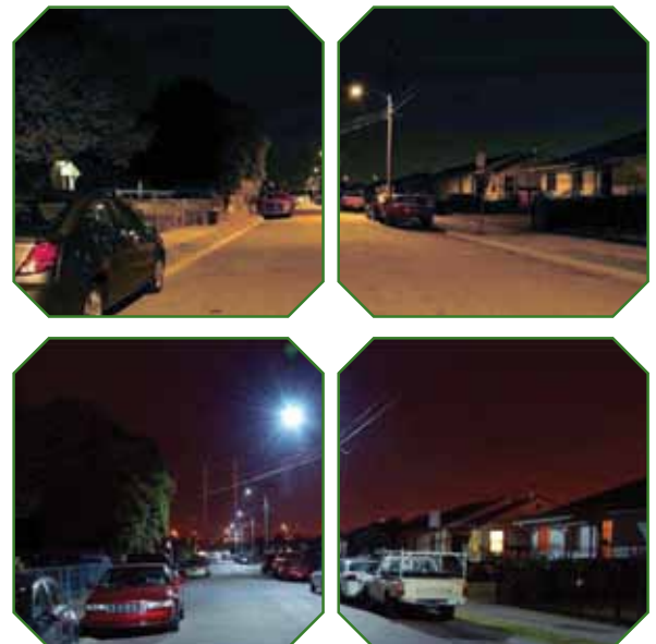
Iluminación de una calle usando ampolletas HPS (arriba) y LED's (abajo). Las ampolletas de sodio HPS típicamente dan un color amarillo-anaranjado, tienen corta vida útil, y contienen Mercurio. (Fotos cortesía de U.S. DOE Solid-State Lighting Projects)
